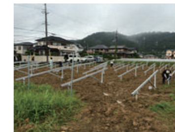
▲架台組立&パネル張り
