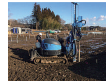
▲エコロープによる先行掘削。重機とツールが繋がっているため、垂直に打てます。
