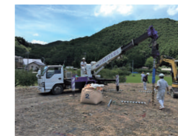
▲平坦で、硬い現場では建柱車による打設も有効
