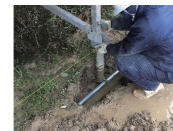
▲スクリュー杭基礎の災害復旧
