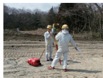
▲現況測量からスクリュー杭の位置出しまで
