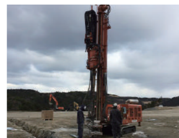
▲高い掘削性能をもつソニックドリルによるスクリュー杭打設の先行掘削
