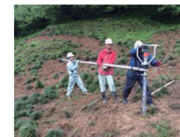
▲急傾斜や重機が入らないような現場では、ハンドタイプの杭打機
