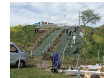
▲防草シート敷き
