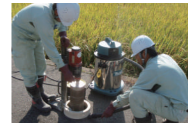
▲コアカッターによる削孔状況
