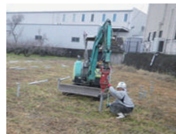
▲定番のバックホーによるスクリュー杭打設
